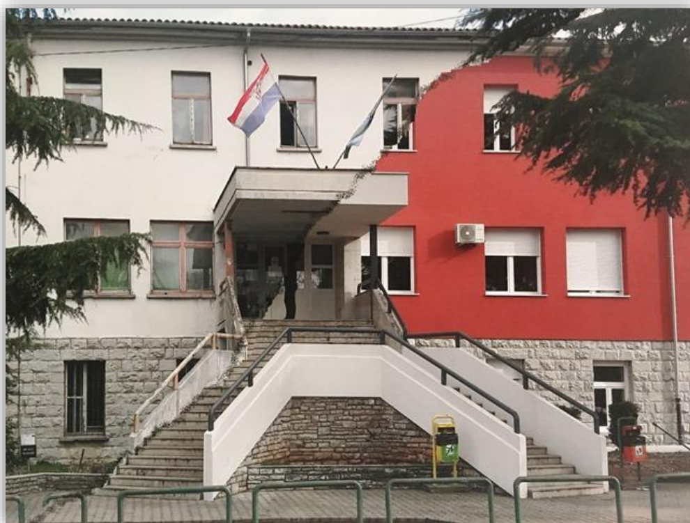
Energetski obnovljena Škola (2018.)
