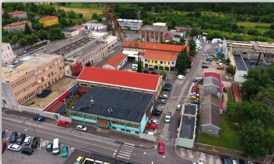
Pogled na školsku radionicu s rekonstruiranim krovom u starijem dijelu Više: http://www.ssmb.hr/636/energetska-obnova-srednje-skole-mate-blazine
